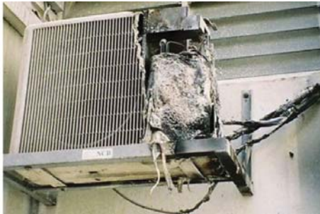
Şekil 1. Yangın olan bazı dış üniteler
