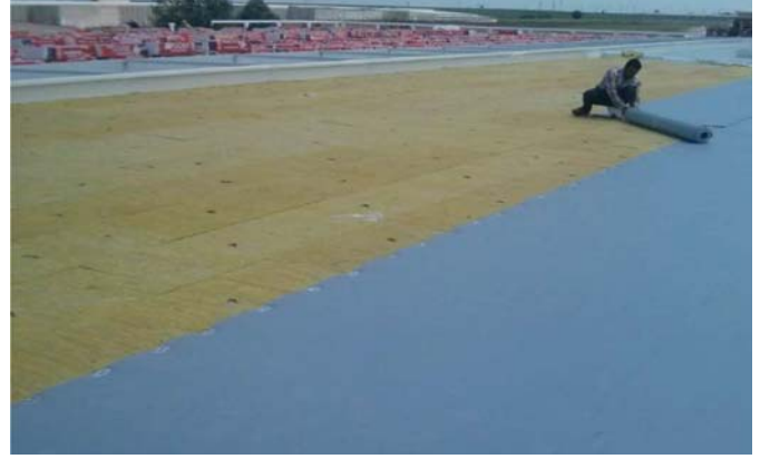
Resim 2 : Çatılarda Yangın Yalıtımı Uygulama Örneği
