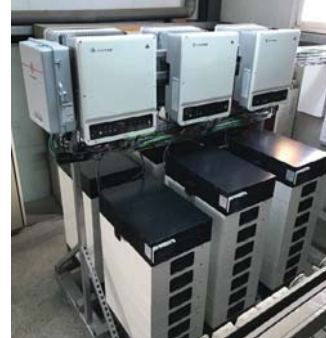
8 ADET GOODWE ET SERİSİ HİBRİT İNVERTÖRLERDEN OLUŞAN İSPANYA'DAKİ 80KW GÜNEŞ ENERJİSİ DEPOLAMA SİSTEMİ
