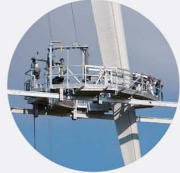
Kanat Bakım ve Onarım
